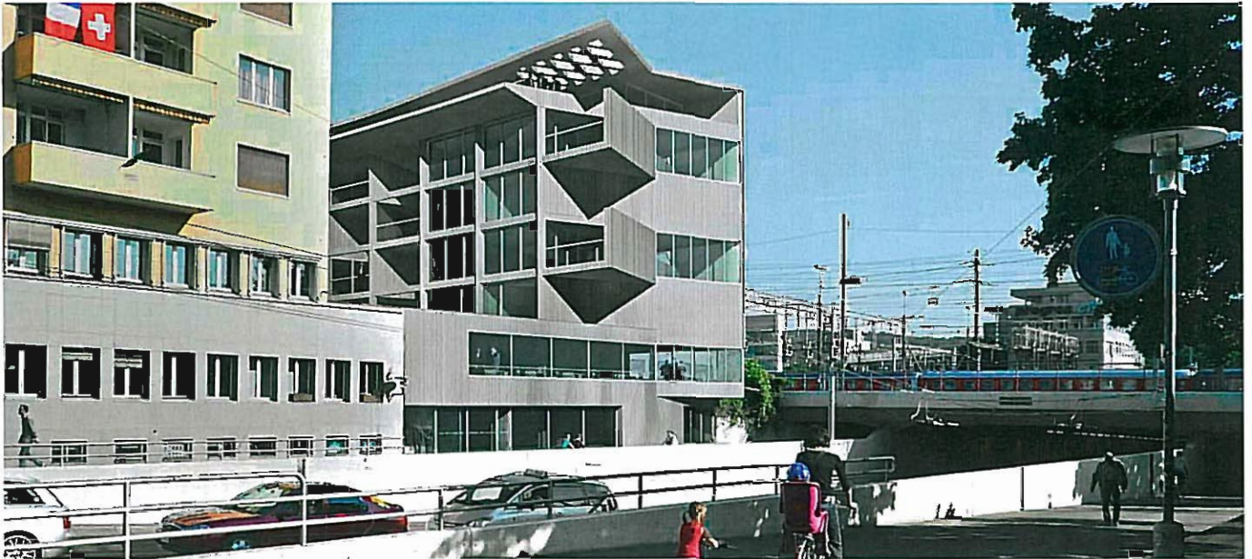
Die Kopffassade an der Langstrassenunterführung
